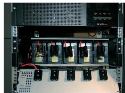
Questo permette ad un singolo operatore di poter installare facilmente il Battery Box e successivamente i Battery Pack al suo interno.
