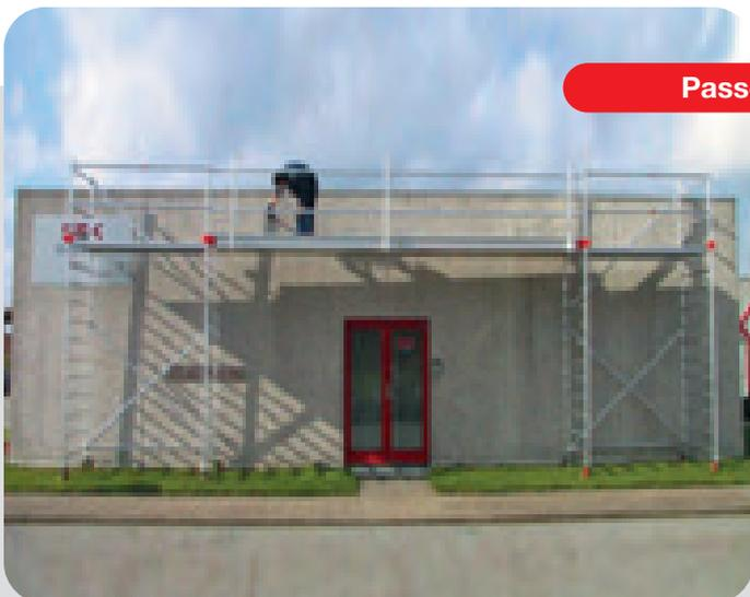
Passa-Tempo è un sistema di passerella fino a 7 m in alluminio estremamente leggero e maneggevole. Le passerelle possono essere unite e formare un piano di calpestio unico od essere capovolte per diventare una passerella singola dotata di fermapiede integrato. Ogni passerella è dotata di ganci in acciaio alle estremità per essere montate su tubi Ø 50 mm (Tempo Tech). Bastano pochi minuti per ottenere un camminamento comodo, leggero ed inattaccabile dalla ruggine.
