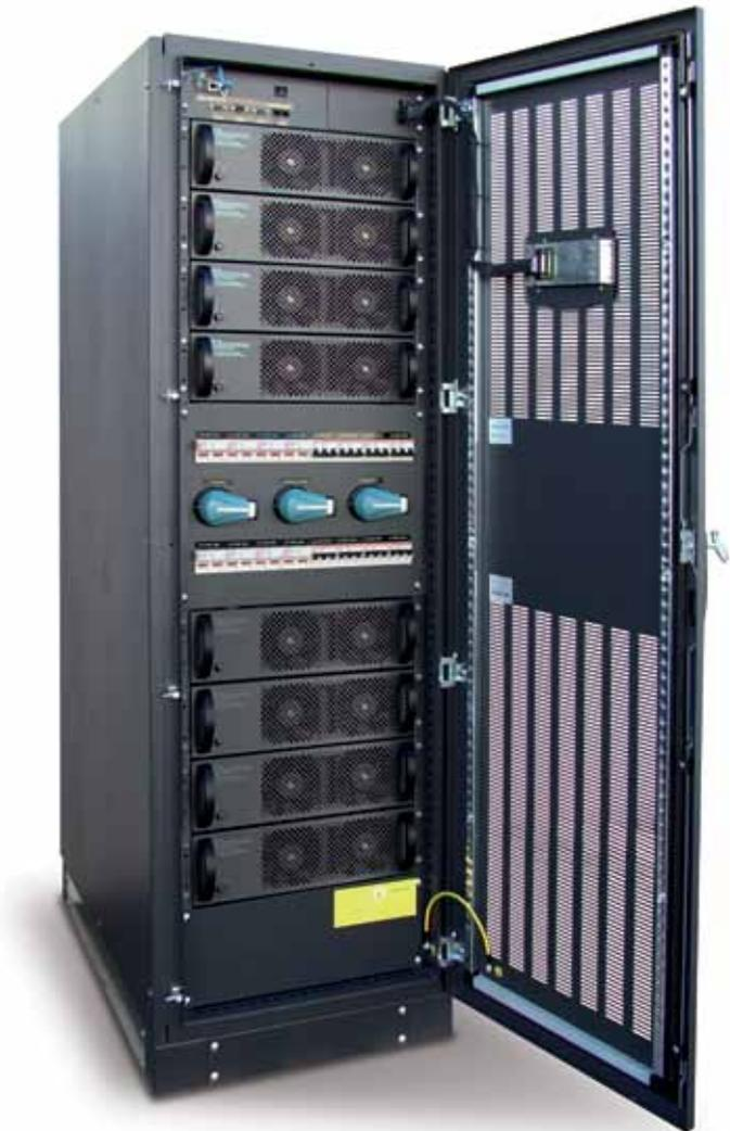
L'UPS modulare Multi Guard 15-120 è un gruppo di continuità scalabile trifase/trifase con tecnologia a doppia conversione: la sua gamma di potenza varia da 15 kVA a 120 kVA offrendo la migliore combinazione di affidabilità, funzionalità, e flessibilità. La configurazione in parallelo N+X di Multi Guard 15-120 adotta un design modulare altamente intelligente che permette di raggiungere la massima disponibilità di potenza e ridondanza.
